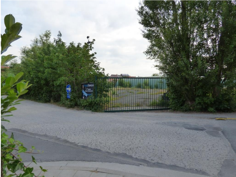
Inkomzijde – kant Centrumstraat
